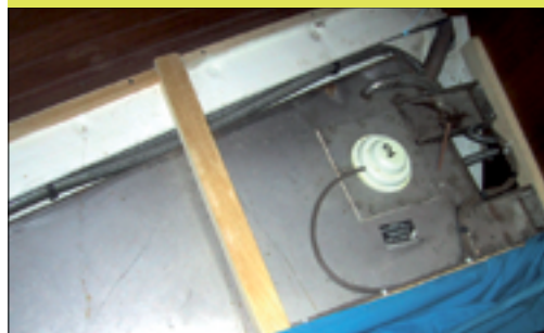
Serbatoio in acciaio inox, con galleggiante pneumatico.
