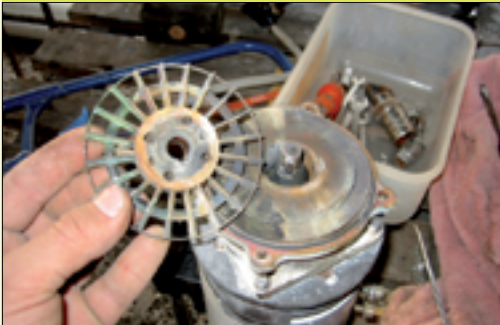
Pompa elettrica con girante usurata, che frizionava contro il corpo pompa.
